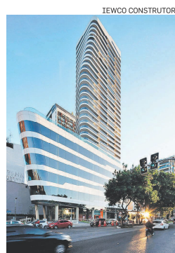
Executivo diz que localização pedia um ‘edifício icônico’
