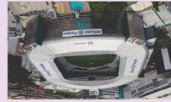
Edo Rocha Arquiteturas Case: Allianz Parque São Paulo (SP) Soluções Arquitetônicas
