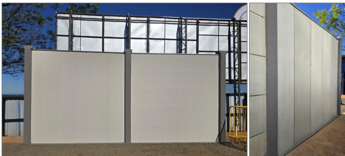
Exemplo de aplicação dos painéis monolíticos para execução de muros.
