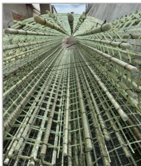
Telas e armaduras em GFRP (Polímero Reforçado com Fibra de Vidro).
