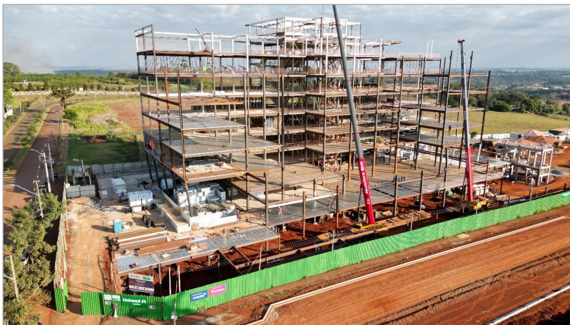
Processo de montagem da estrutura metálica da obra do Hospital Regional Unimed Londrina.
