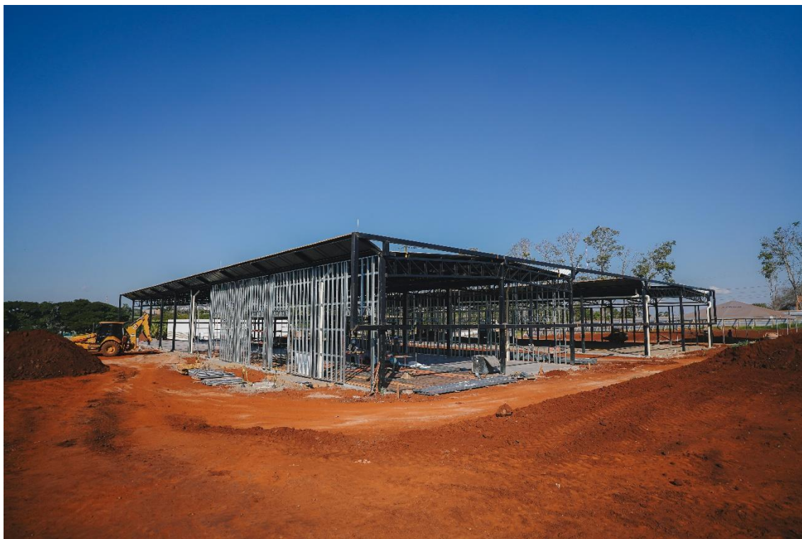
Início da execução dos fechamentos externos em Stell frame no CIT UEL
