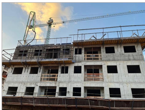
Empreendimento com estrutura no sistema construtivo parede de concreto.
