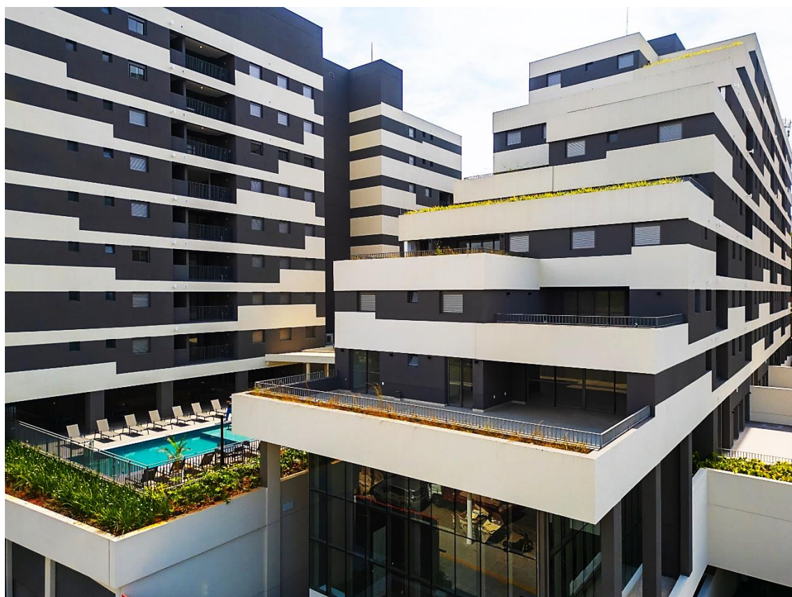
Detalhe da fachada com área da piscina ensolarada
