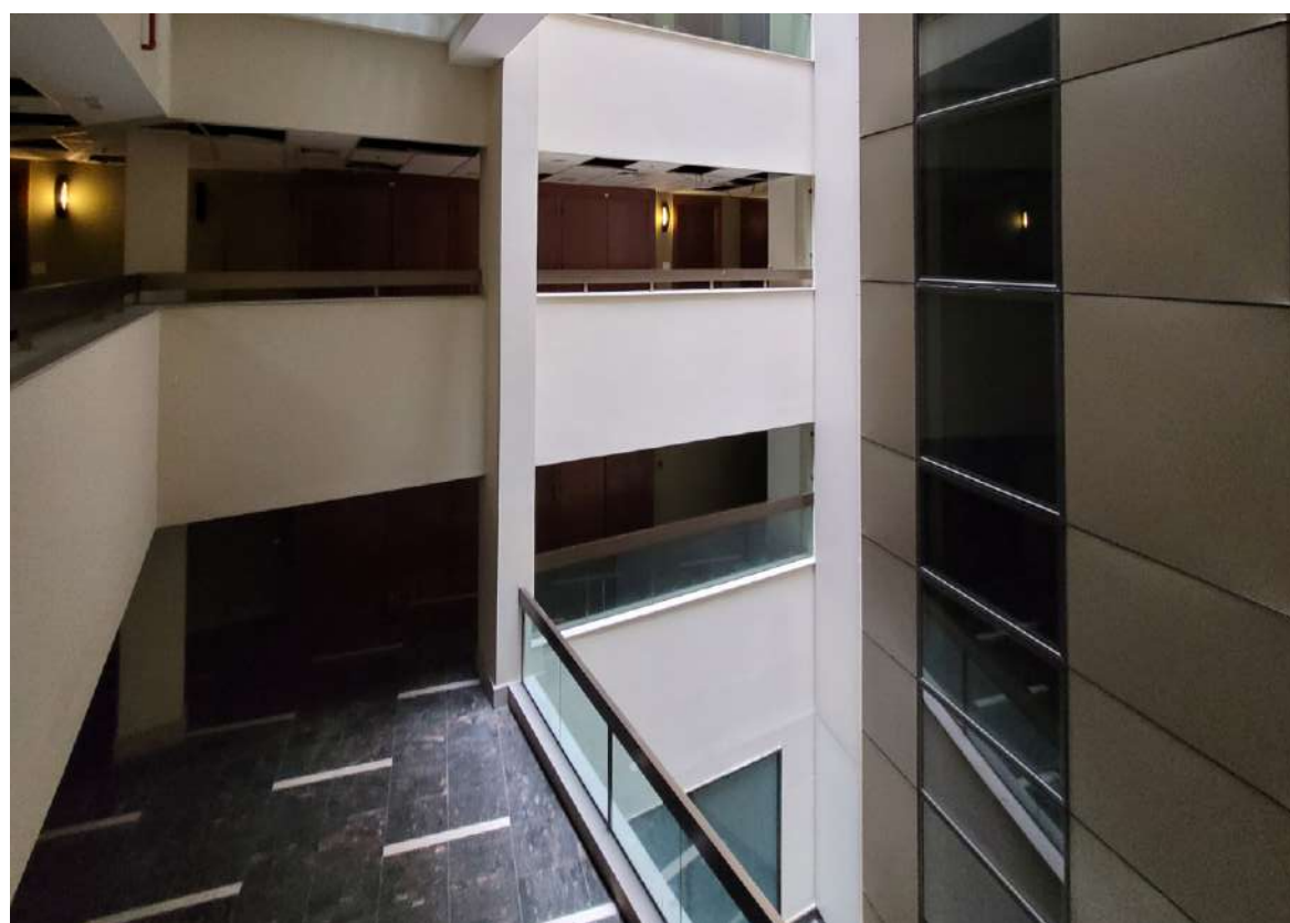
ANTES DO RETROFIT
