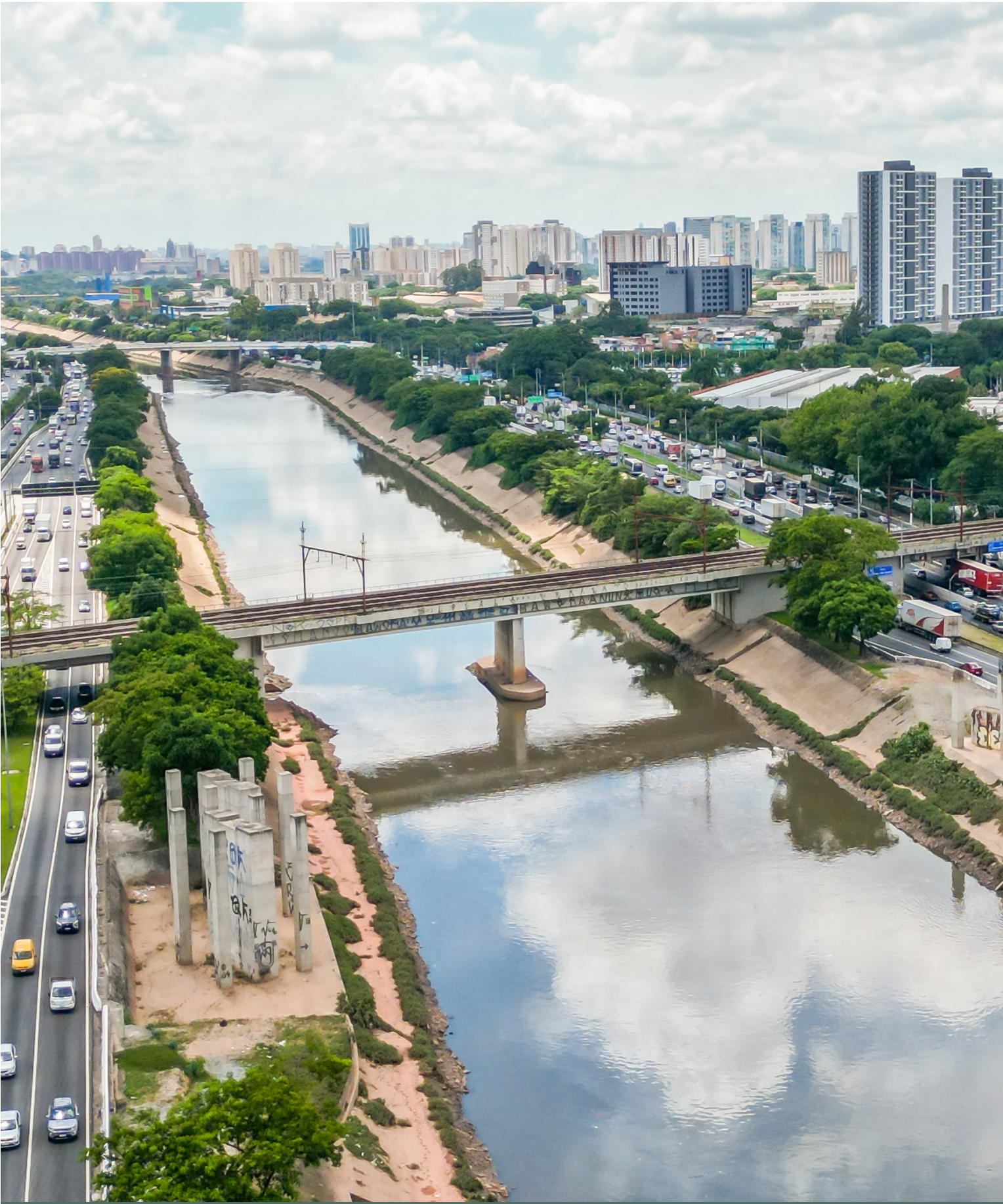
Retomada da construção da ponte Pirituba-Lapa | Prefeitura de São Paulo
