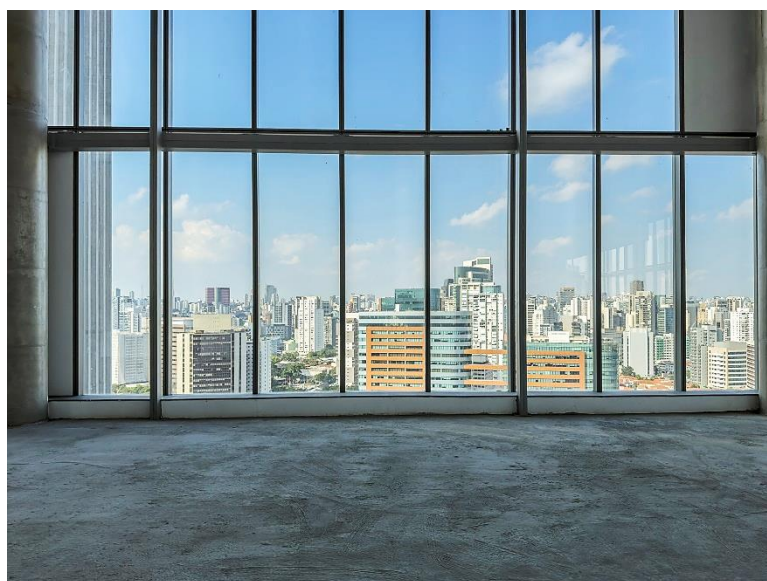
Lajes com iluminação natural
